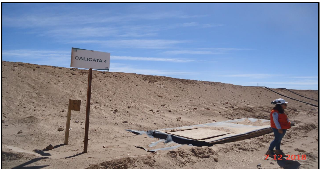
Figura 15. Calicata 4 Control Pretilos
