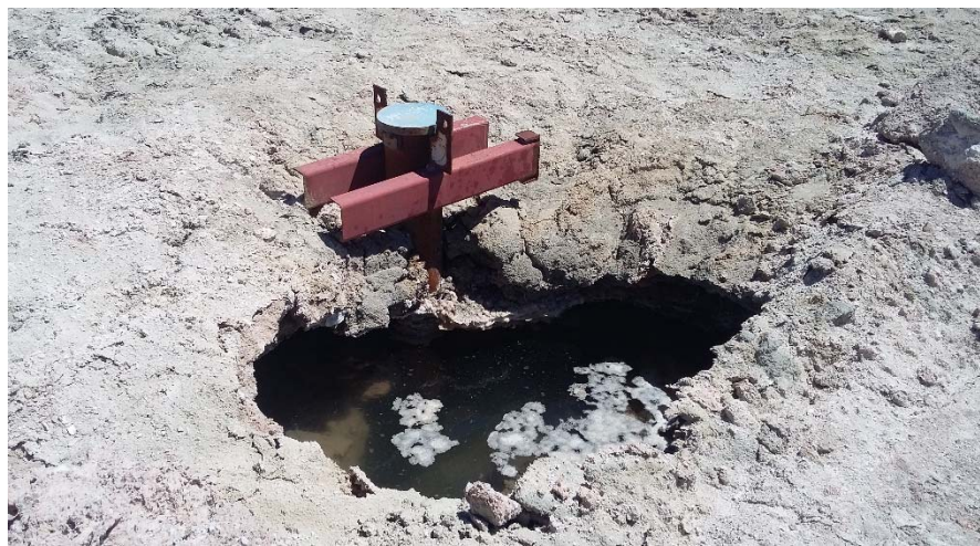
Figura 4: Estado actual del pozo MP-041, afectado por disolución de sal en su borde.
