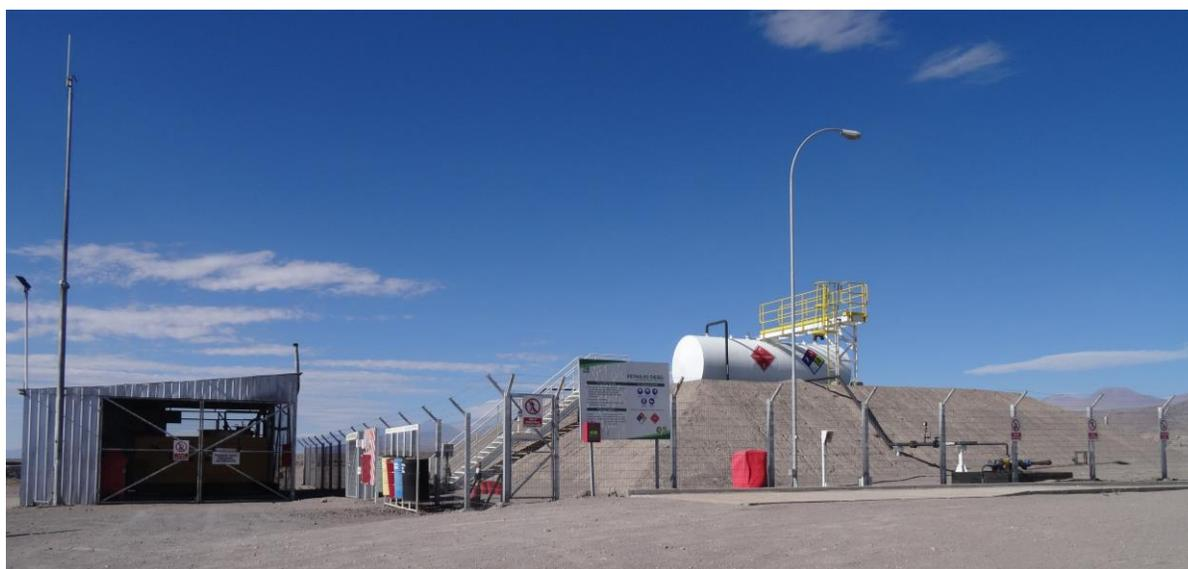
*Figura 8: Vista general pozo de extracción de agua Camar donde se aprecia sistema de disposición segregada de residuos sólidos domiciliarios, tanque de combustible área de generadores y señalética general.*
