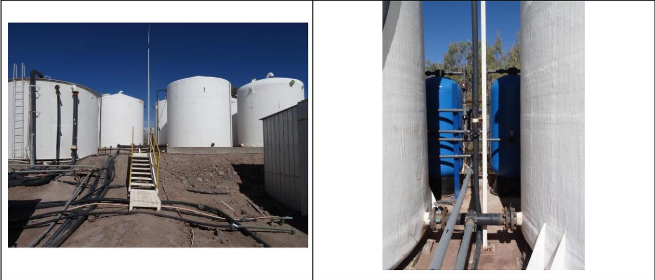
*Figura 12: Sistema de plantas osmosis inversa para potabilización de agua para uso en servicios higiénicos de Campamento Andino, tanques de almacenamiento agua potable y abatidores de arsénico.*
