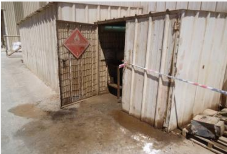
Fotografía N° 23 Sector de lavado partes y piezas, Taller de mantención
