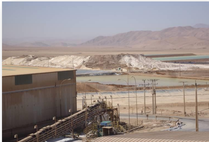
Fotografía N° 17 Vista poza de descarte de residuos sólidos
