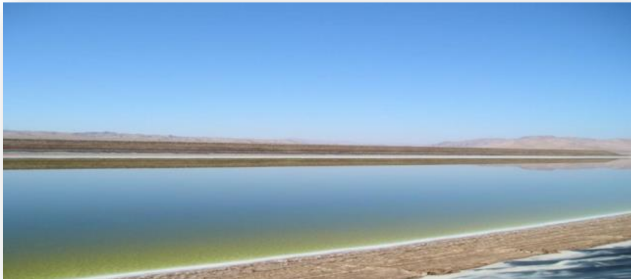
Fotografía N° 15 Vista pozas de descarte de RILES.
