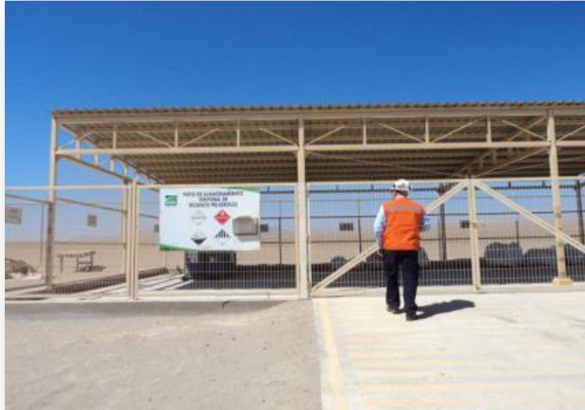
Fotografía N° 19 Nuevo patio de almacenamiento temporal residuos industriales peligrosos
