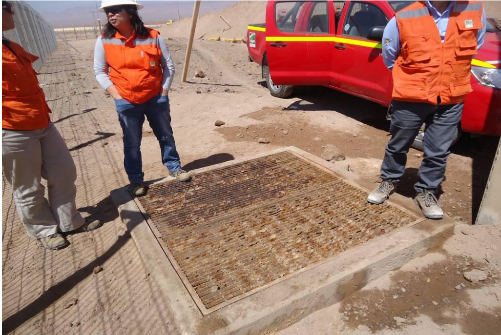
Fotografía 12. Vista sistema de inspección de infiltración
