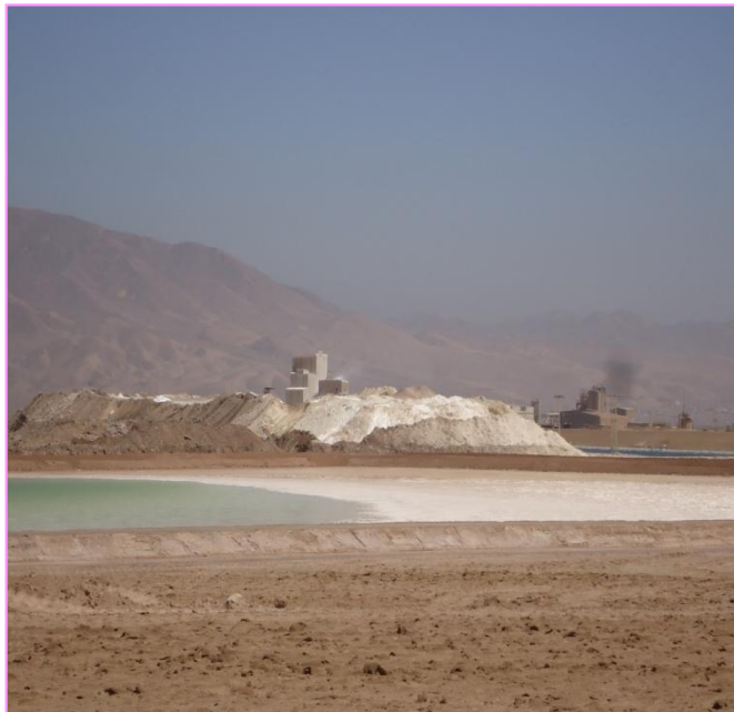
Fotografía N° 10 Poza de Sólidos
