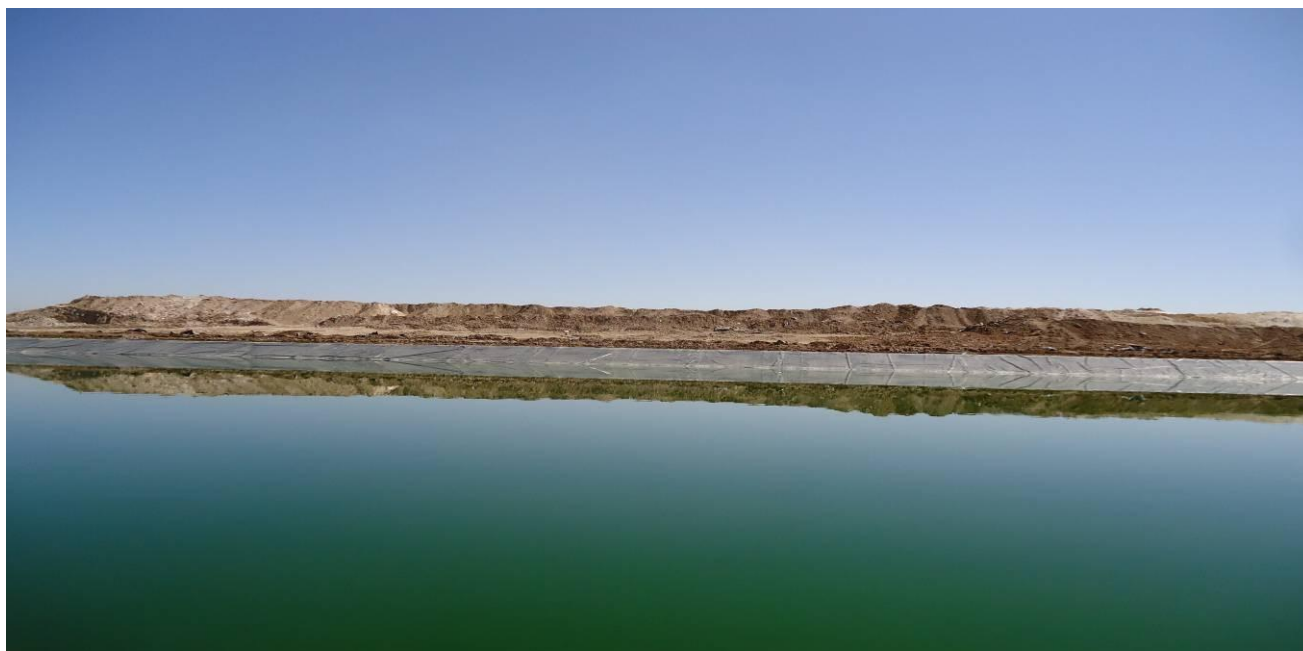
Fotografía N°15. Vista pozas de descarte de RILES.
