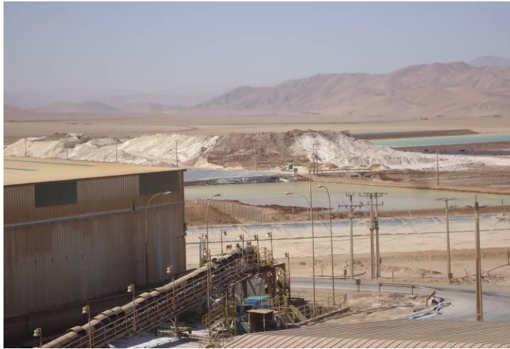
Fotografía N° 16. Vista poza de descarte de Residuos Sólidos
