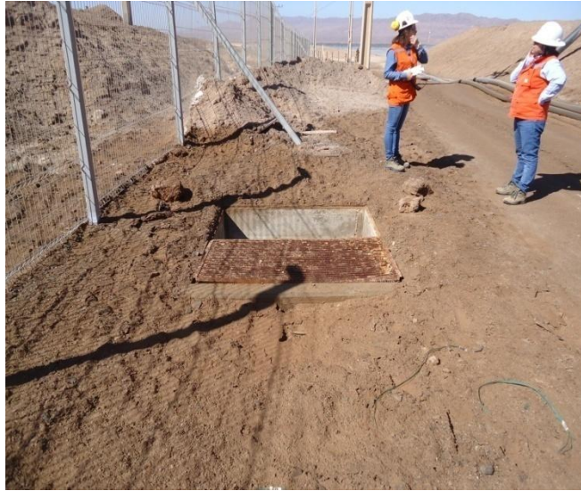
Fotografía N° 20 Cámara de Inspección
