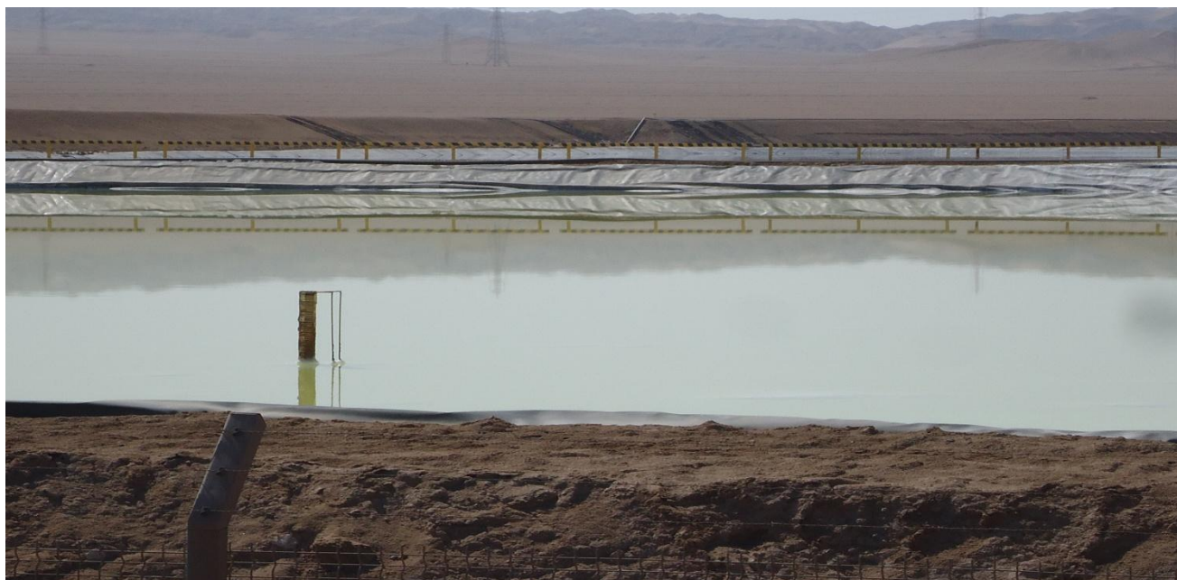
Fotografía N° 9: Vista pozas de descarte de RILES.
