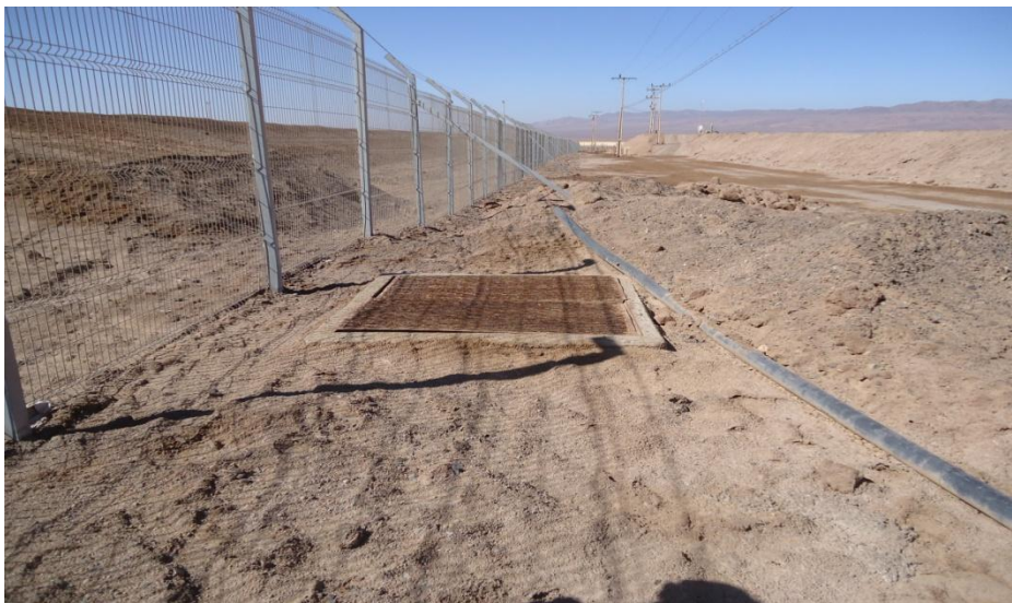
Fotografía N° 6: Cámara de Inspección
