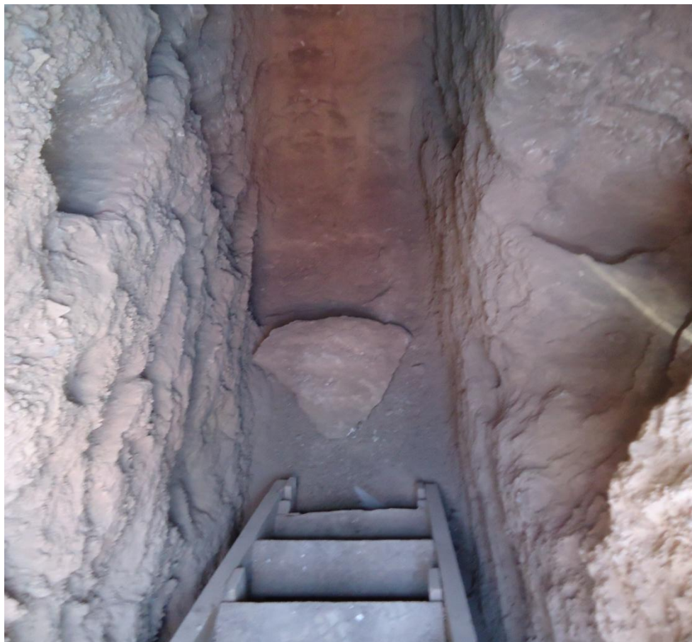
Fotografía N° 13: Cámara inspección filtraciones pozas
