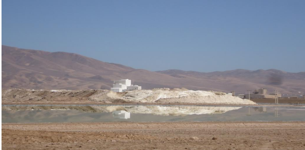
Fotografía N° 10: Vista poza de descarte de Residuos Sólidos
