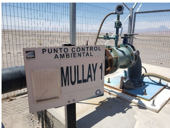
Figura 10: Ubicación bomba y flujómetro de bombeo extracción de agua industrial Pozo Mullay.
