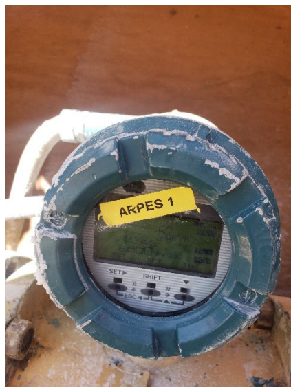
Figura 1: Canaleta Arpes y flujómetros en líneas de bombeo Arpes 1 y Arpes 2.
