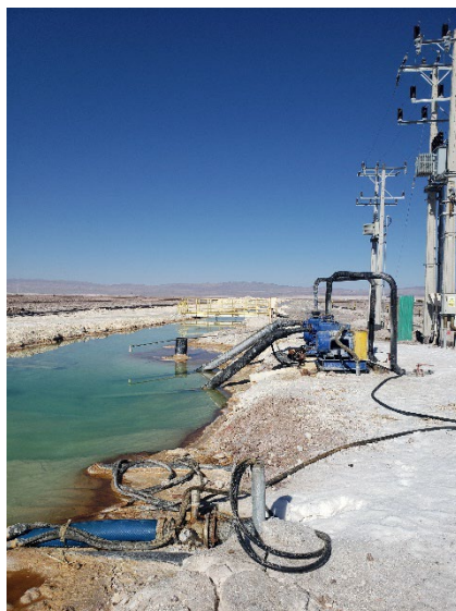
Figura 1: Canaleta Arpes y flujómetros en líneas de bombeo Arpes 1 y Arpes 2.
