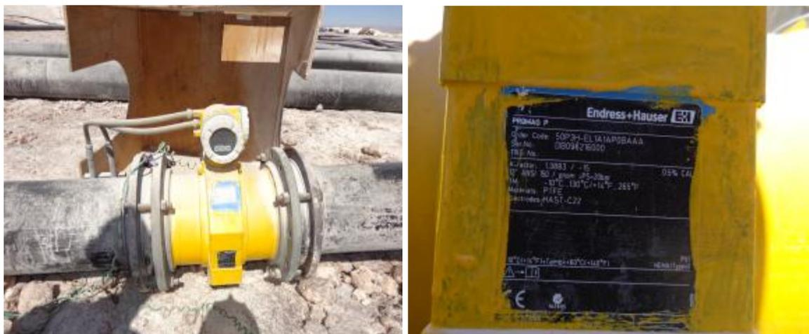
*Figura 1: Flujómetro certificado en operación de bombas de extracción de salmuera, las que cuenta con identificación adecuada.*
