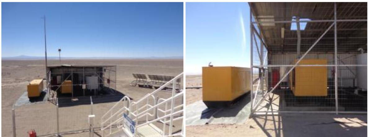
*Figura 8: En pozos de extracción de agua dulce para uso industrial se encuentran abastecido de energía mediante generadores diesel, uno principal y otro de respaldo.*
