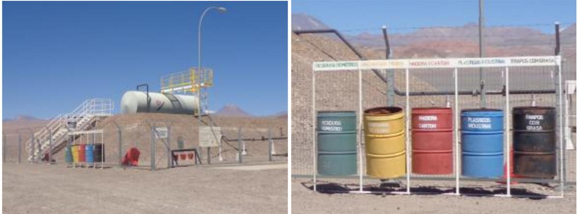
*Figura 5: Sistema de segregación de residuos (islas de residuos) en sector de pozos de extracción de agua dulce para uso industrial.*
