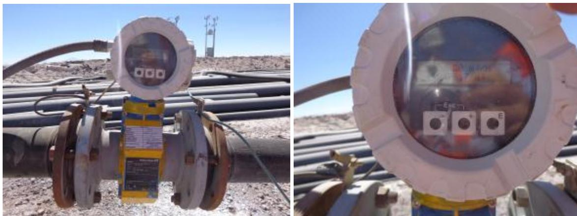
*Figura 2: Flujómetro certificado no operativo por requerimiento de mantenimiento de tuberías de distribución interna hacia pozas de preconcentración de salmuera.*
