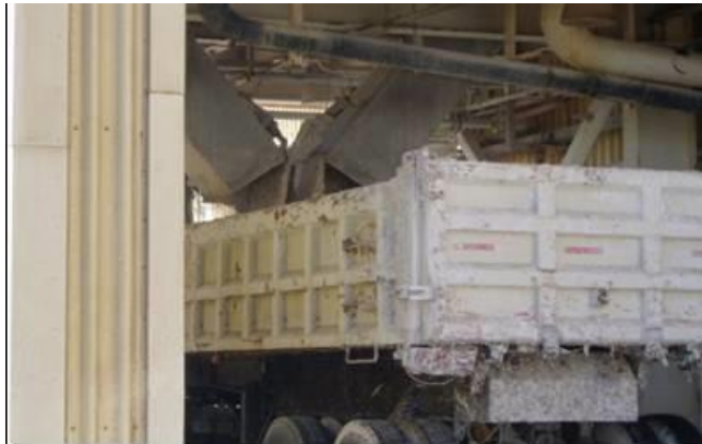
Fotografía N° 8. Tolva descarga de sólidos desde prensa
