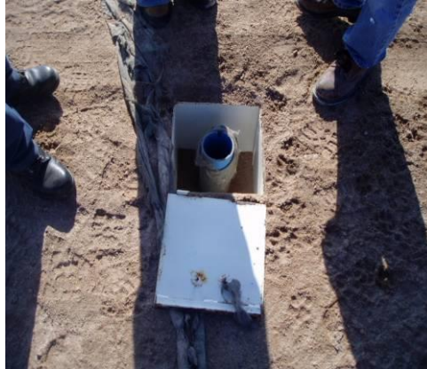
Fotografía N° 9. Vista sistema de inspección de infiltración.
