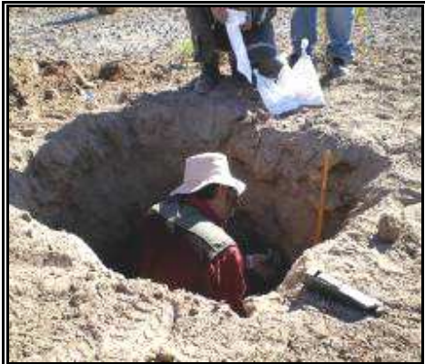
Etapa B: Toma de datos en terreno. Excavación de calicatas
