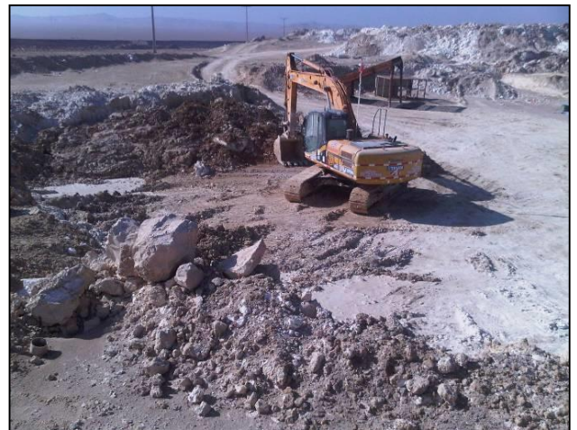
Fotografía N° 8 Tolva de Descarga desde prensa
