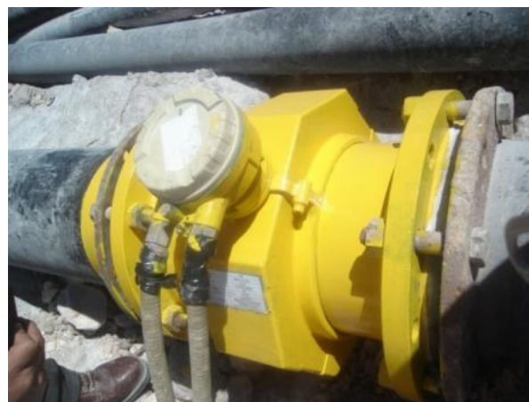
Flujometro en bombas impulsión salmuera
