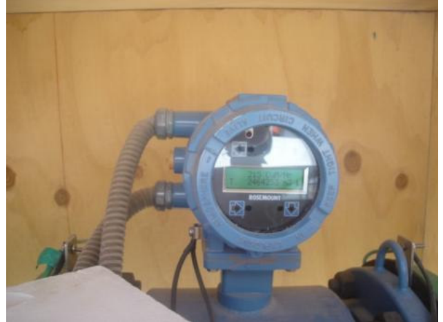
Flujometro en pozo extracción agua (Camar)
