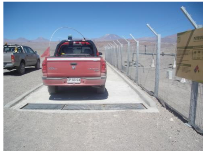
Loza de abastecimiento de petroleo con rejilla captadora de derrames.
