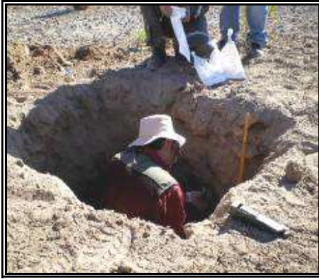
Etapa A: Toma de datos en terreno. Excavación de calicatas
