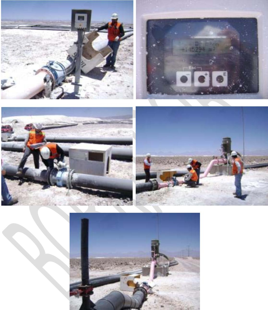
*Figura 3: Revisión de flujómetros certificados en pozos de extracción de salmuera.*
