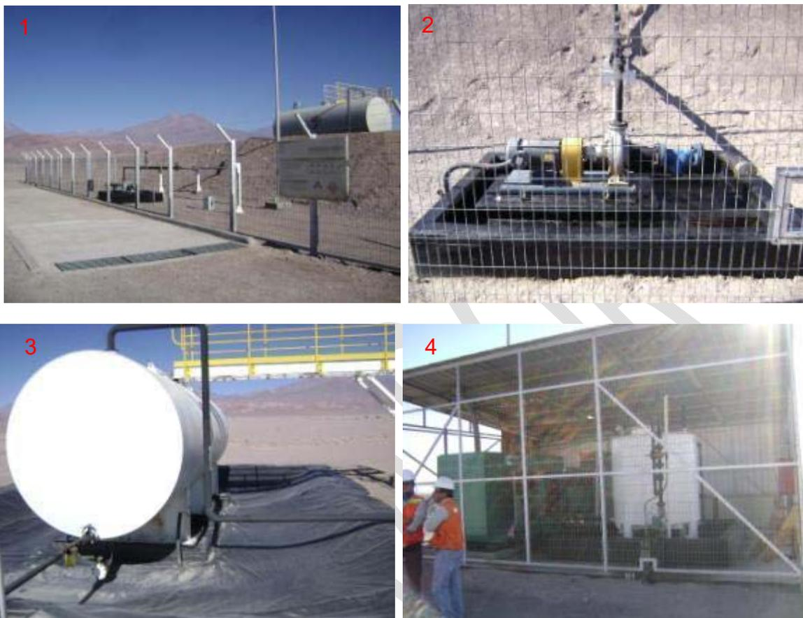
*Figura 6: Manejo de combustibles en pozos de extracción de agua dulce para uso industrial. 1) Área de descarga de combustible de piso sólido y sistema de drenes para el control de eventuales derrames, 2) Sistema de impulsión para carga de estanque combustible principal, 3) Medidas de contención de derrames bajo área de emplazamiento de estanque principal 4) Detalle de estanque de combustible de uso diario el cual también cuenta con sistema de contención ante eventuales derrames.*
