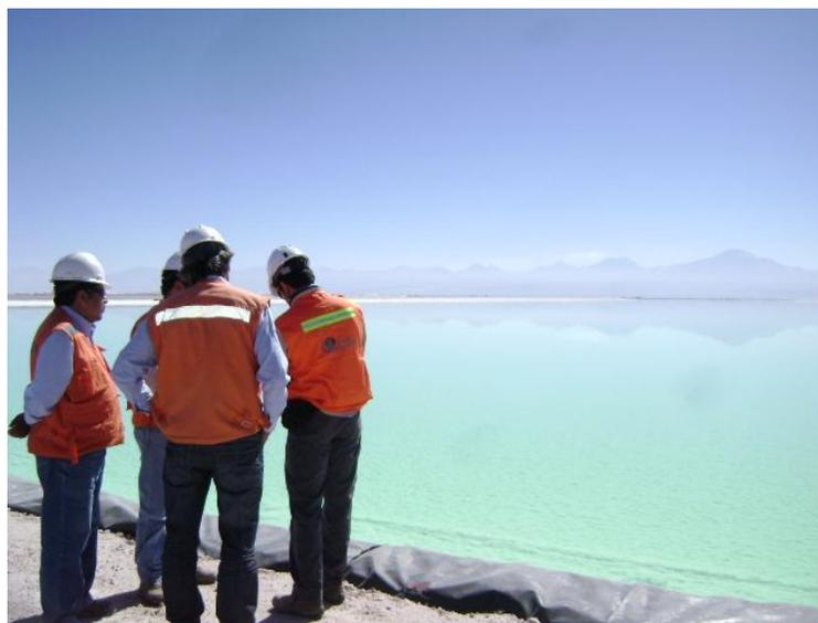
*Figura 1: Piscinas de evapotranspiración para obtención de sales de interés comercial.*
