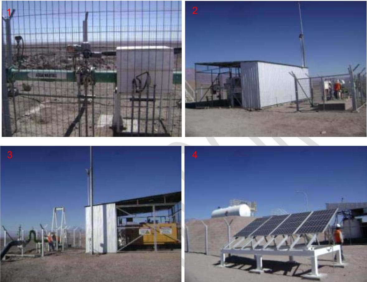
Figura 5: Inspección de pozos de extracción de agua potable y de proceso. 1) Sistemas de extracción y flujómetros, 2) Instalación vista hacia el este, 3) Instalación vista hacia el oeste y 4) sistema de abastecimiento de energía solar para luminarias.
