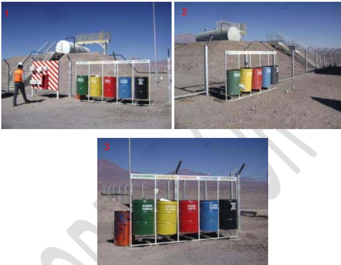
Figura 7: Seguridad y manejo de residuos sólidos en área de pozos de extracción de agua. 1) Puntos de manejo de elementos de seguridad y 2 y 3) Unidades de manejo segregado de los residuos.
