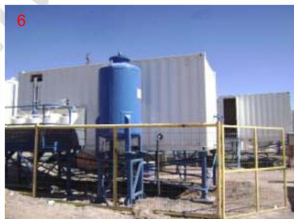
*Figura 4: Revisión de plantas de tratamiento de aguas servidas en Campamento Andino 1) y 2) Unidad de sanitizado por acción UV, 3) y 4) Unidades de tratamiento de aguas servidas y 5 y 6) Plantas de osmosis inversa.*
