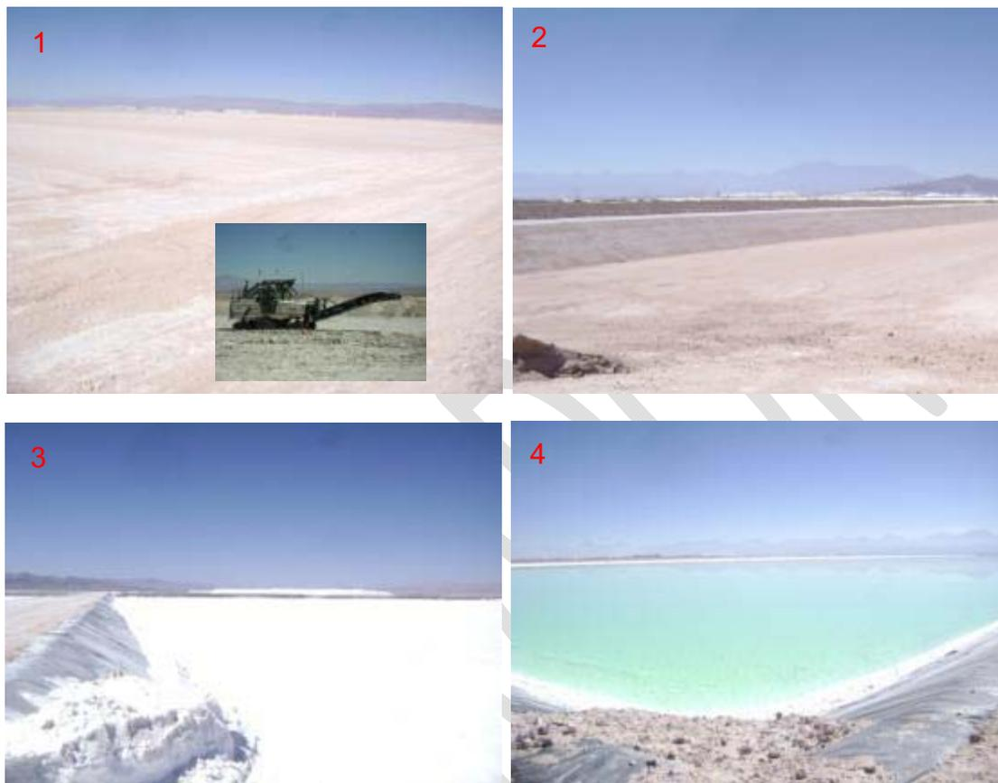
*Figura 1: Procedimiento de construcción de piscinas de proceso para obtención de sales de interés comercial. 1) Construcción de piscina y equipo utilizado en ello, 2) Perfilado de taludes, 3) Aplicación de capa de HDPE más sello de piscina y 4) Piscina en operación.*
