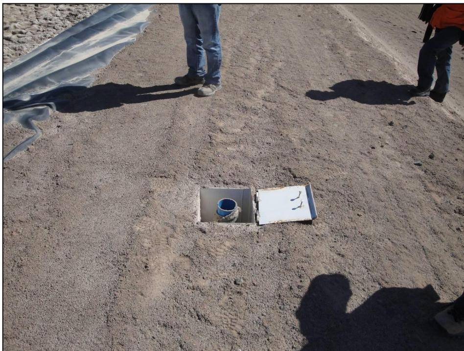
Como mitigación el proyecto consideró un sistema de impermeabilización o protección contra infiltración de líquidos a suelo y subsuelo en tres láminas, de la siguiente forma: una lámina de fondo de geotextil de  $300 \text{ g/m}^2$ , una lámina intermedia formada por un polietileno de alta densidad (HDPE) de 1mm de espesor y una lámina de geotextil de  $150 \text{ g/m}^2$ , con un sistema de pozo profundo para determinar filtraciones entre pozas.
