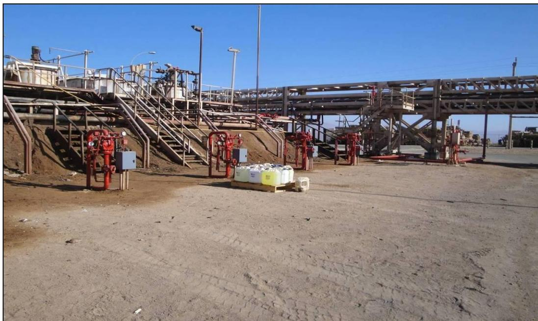
En esta unidad se remueve el boro mediante un proceso de extracción por solvente, a través de procesos de acidificación con ácido clorhídrico, cristalización en la forma de ácido bórico y extracción por solvente del boro en unidades mezclador-decantador.
