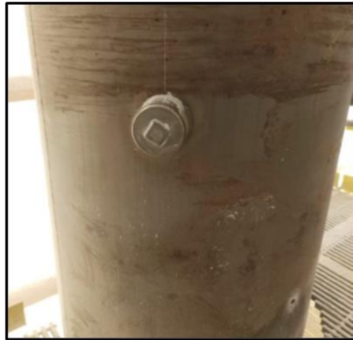
Fotografía 21 y Fotografía 22. Puntos de Muestreo Isocinéticos Calderas N° 1 y Secador N° 3 (Fuente Informes anteriores de Proterm)
