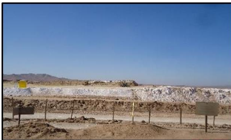
Fotografía 25. Vista poza de descarte de RIS
