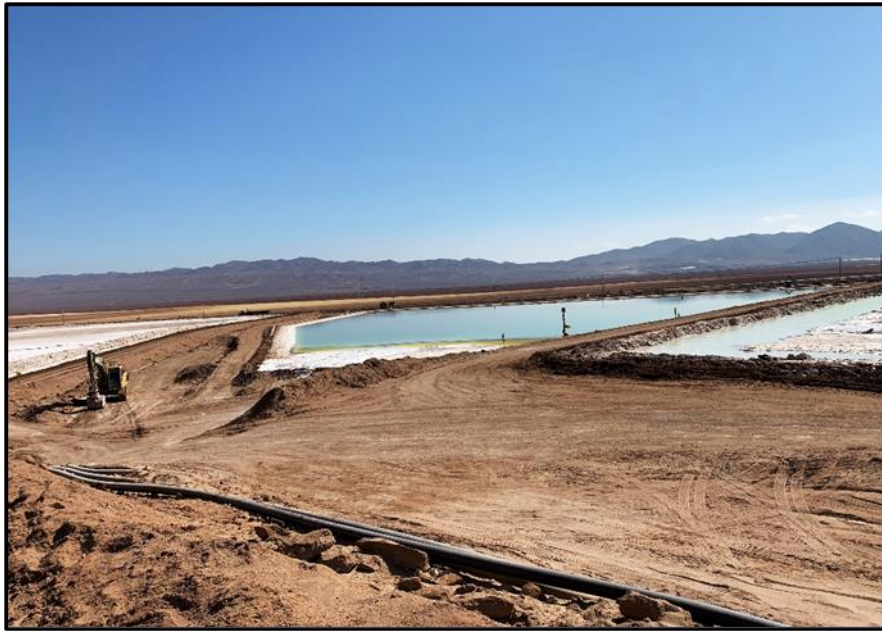
Fotografía 16 Pozas de descarte RIL
