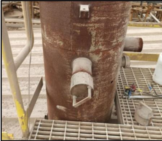
Fotografía 21 y Fotografía 22. Puntos de Muestreo Isocinéticos Calderas N° 1 y Secador N° 3 (Fuente Informes anteriores de Proterm)
