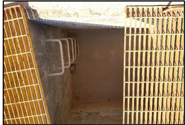
Fotografía 10 Interior Cámara de Registro
