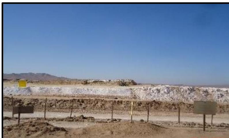
Fotografía 25. Vista poza de descarte de RIS
