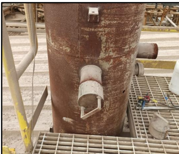
Fotografía 21 y Fotografía 22. Puntos de Muestreo Isocinéticos Calderas N° 1 y Secador N° 3
