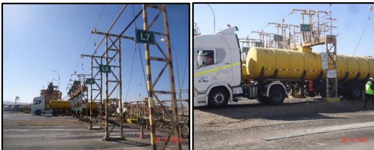
Fotografía 2 y Fotografía 3: Área recepción de salmueras o solución de cloruro de litio alto boro
