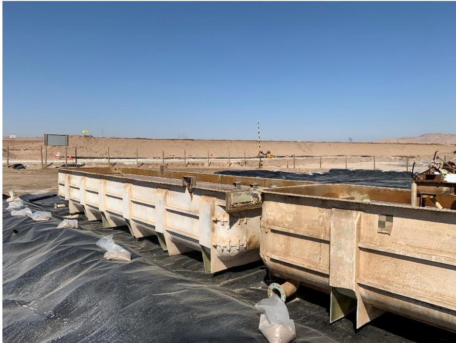
Fotografía 29. Sector de Almacenamiento Temporal Residuos No Peligrosos
