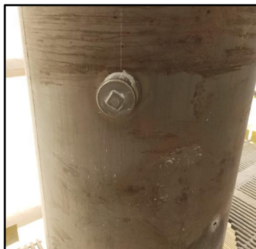
Fotografía 21 y Fotografía 22. Puntos de Muestreo Isocinéticos Calderas N° 1 y Secador N° 3
