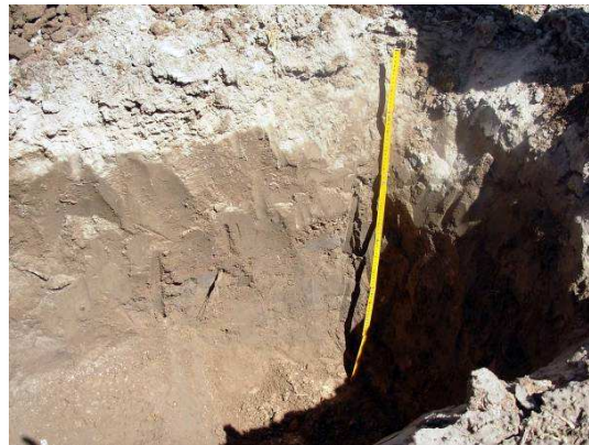
Perfil de la Calicata
