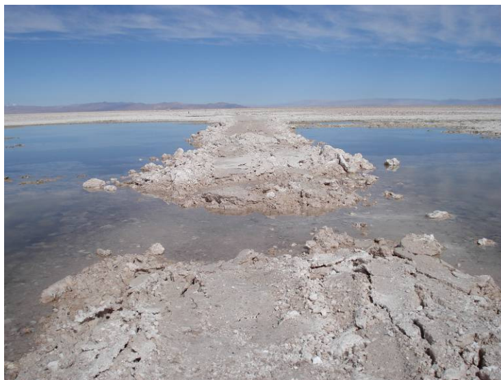
Foto 4-4. Vía de acceso interrumpida por escurrimiento superficial en Perfil D1
