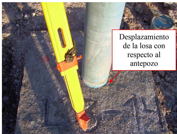
Foto 4-7. Desplazamiento de la losa con respecto al antepozo del Pozo L3-14
