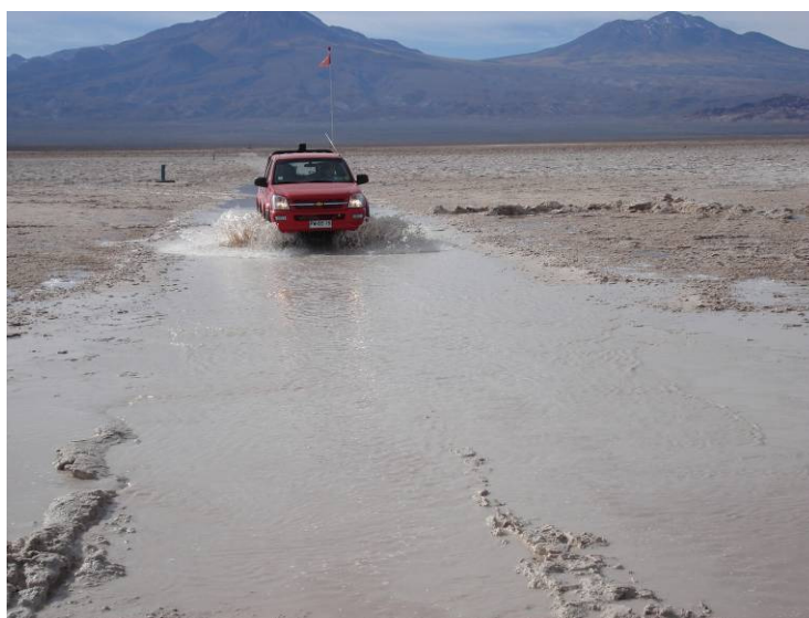
Foto 4-5. Vía de acceso parcialmente interrumpida por escurrimiento superficial en Perfil D4
