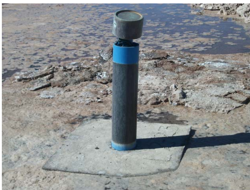
Fotografía 4.2. Estructura del Pozo L2-23 modificado por ingreso de agua dulce.
