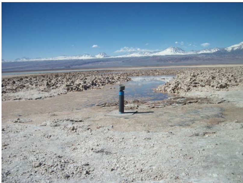
Fotografía 4.1. Plataforma del Pozo L2-23 destruida por ingreso de agua dulce. Vista Oeste-Este
