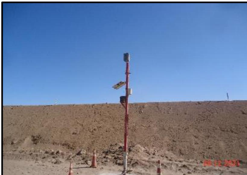
Fotografía 29 Sistema Ahuyentadores de Aves Espejos de Agua Piscinas
