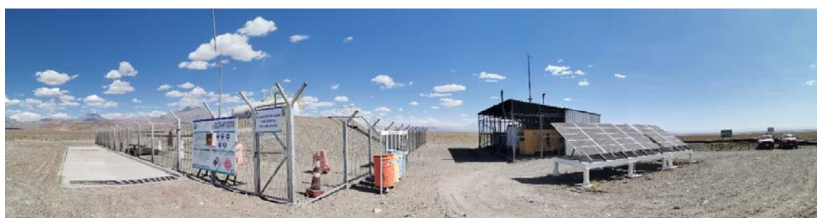
Figura 11: Vista general de instalaciones del pozo de agua industrial Allana 1, estanque de diésel y equipo generador.
