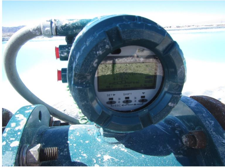
Figura 3: Certificado y flujómetro de línea de bombeo Poza de Mezcla
