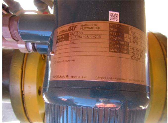
**Figura 13: Flujómetro y placa de línea de bombeo extracción de agua industrial Pozo Socaire**
