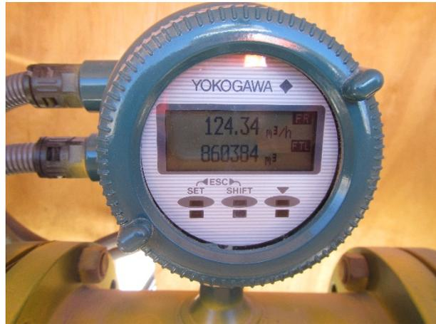
**Figura 14: Vista general y flujómetro pozo extracción de agua industrial CA-2015 (sector Campamento Andino)**
