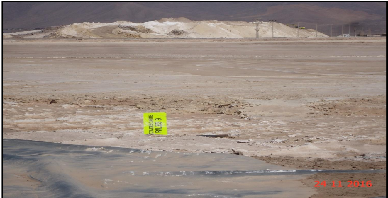
Fotografía N° 8: Vista pozas de descarte de RILES.
