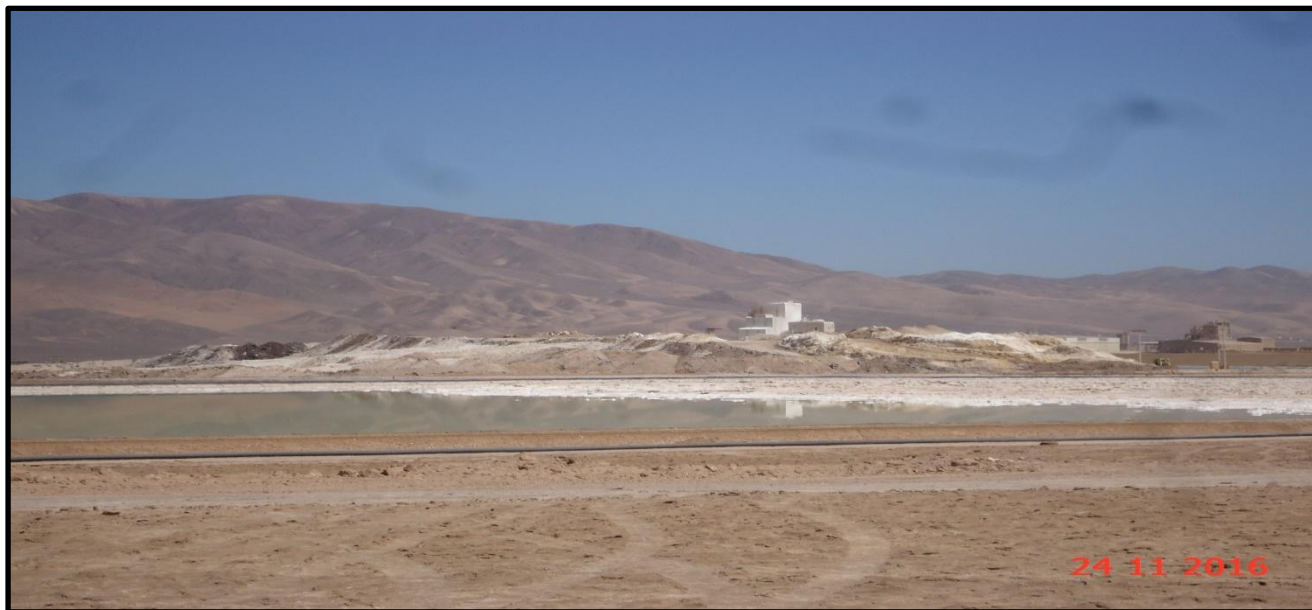
Fotografía N° 9: Vista poza de descarte de Residuos Sólidos
