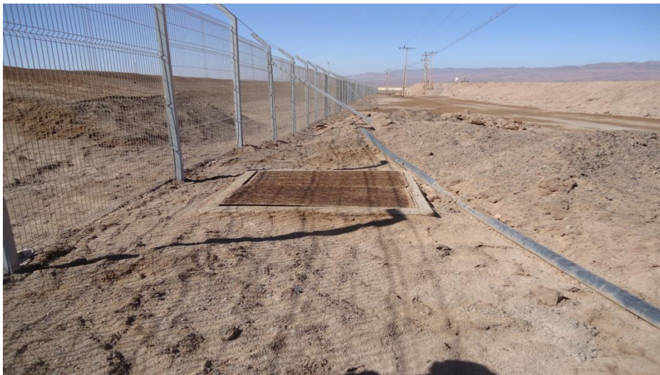
Fotografía N° 6: Cámara de Inspección
